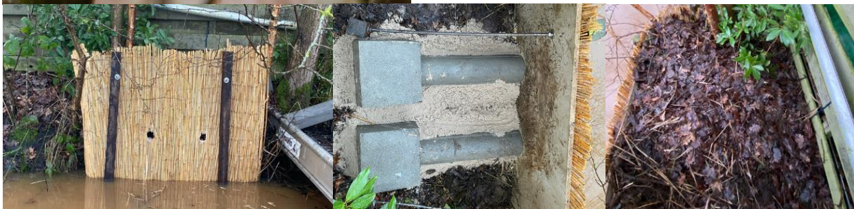
Foto 67: de aanliegroute Foto 68: bovenaanzicht bij de aanleg. Foto 69: bovenaanzicht klaar. Foto's: Jochem Duijts.
