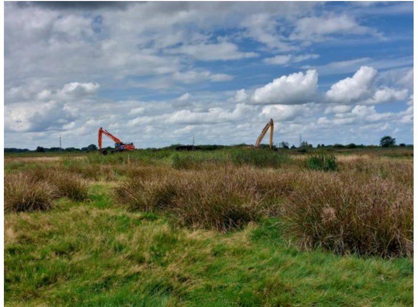
Afbeelding 13 De werkzaamheden in de Weeringsbroeken. Van de afgegraven grond worden aan de rand kades aangelegd.
